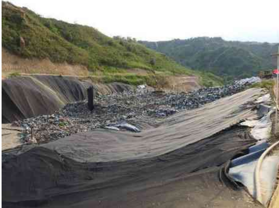
Fotografía 8: Ausencia de gallinazos en la celda de respaldo 2, inicio de llenado (12/04/2021) EMAB.
