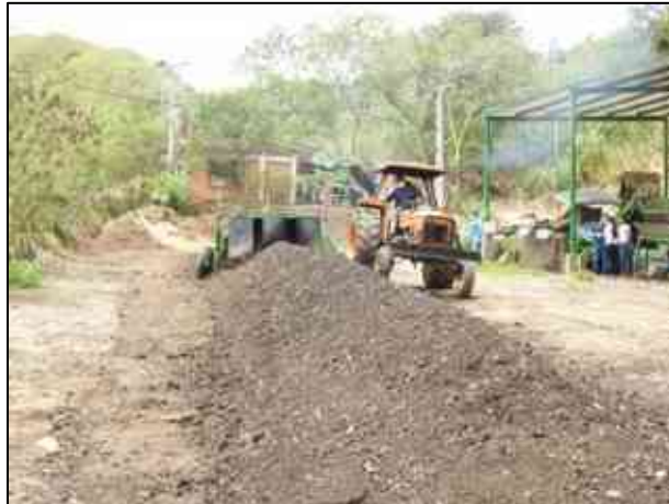
Fotografía. Volteos mecánicos en pilas de descomposición.
