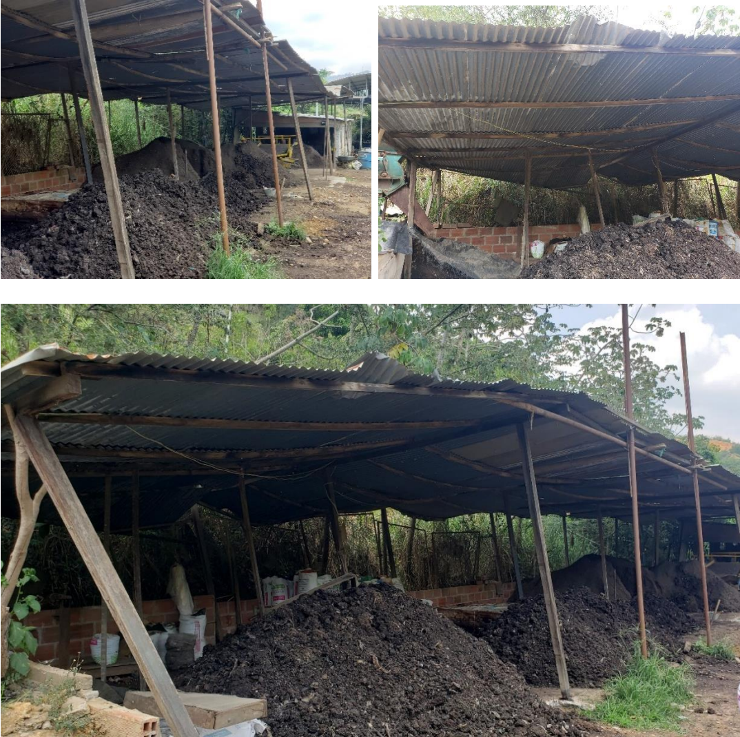
Ilustración 1. Estado de las instalaciones de la planta de compostaje tras las lluvias de enero y febrero de 2022.
