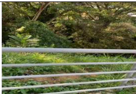
Instalación nuevo pasa manos
