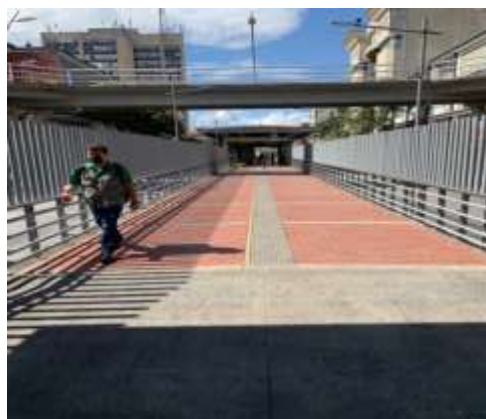
Pintura de barrotes e instalación de luminarias
