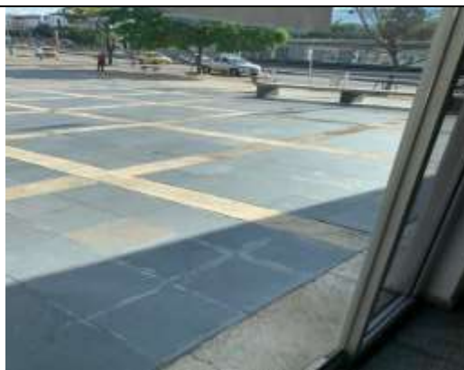
Reparación de lozas por filtración en oficinas
