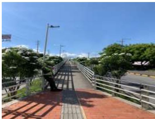
Instalación de Luminarias
