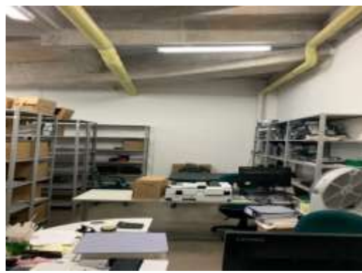
Pintura y luminarias en el archivo del
