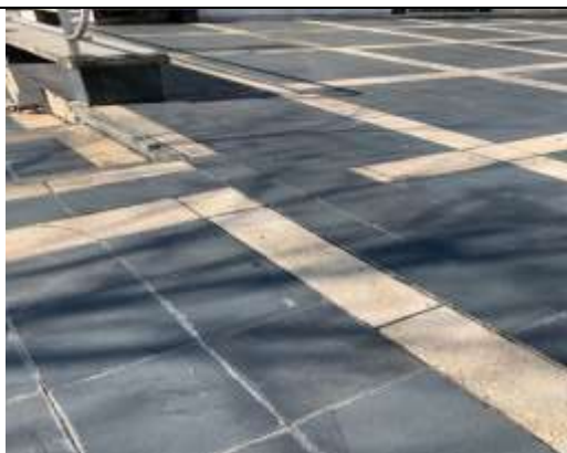
Reparación de lozas por filtración en oficinas
