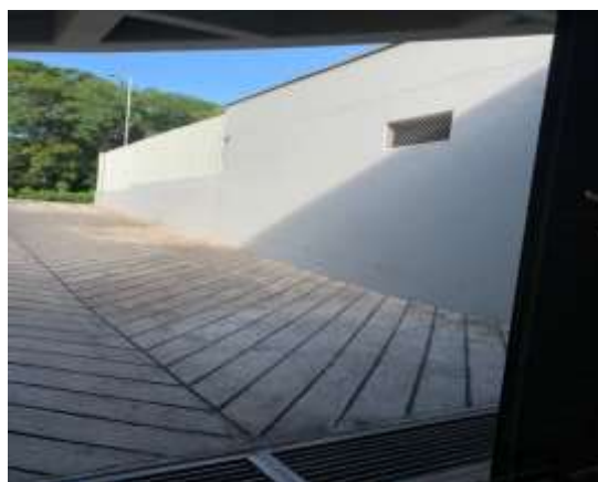
Pintura muro exterior y barrotes.
