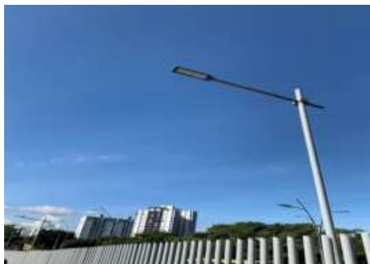
Reemplazo e instalación de luminarias
