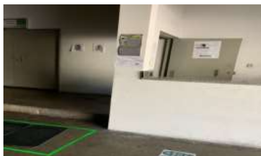
Pintura muros interiores sótano
