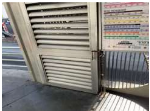
Reparación de puertas
