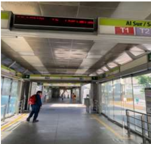
Señalética, cambio de luces a led.
