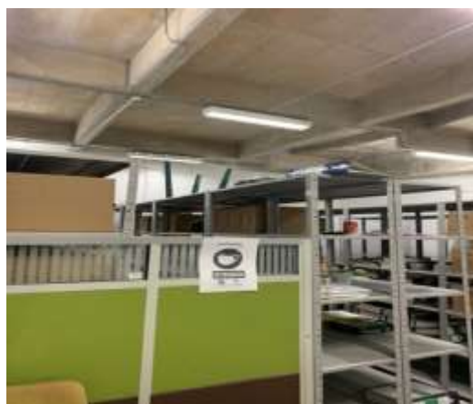
Pintura y luminarias archivo sótano
