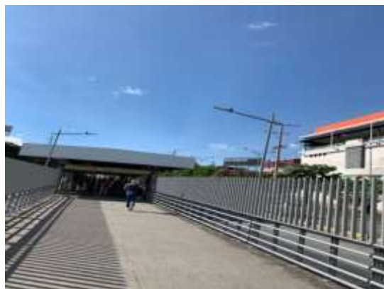
Pintura de barrotes, instalación de luminarias
