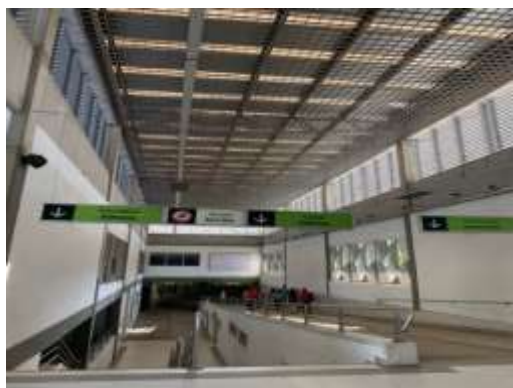
Reparación cubierta central
