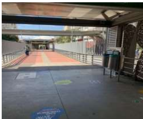
Pintura de barrotes e instalación de luminarias
