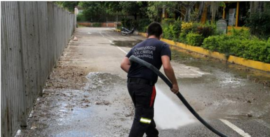
Reparación de plomería al costado externo de la pista del Centro Diagnóstico.
