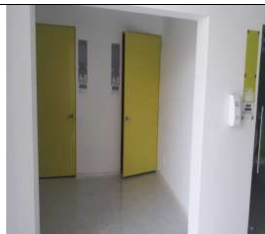
Remodelación de espacios internos
