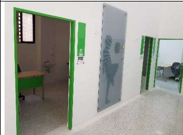
Remodelación de espacios internos
