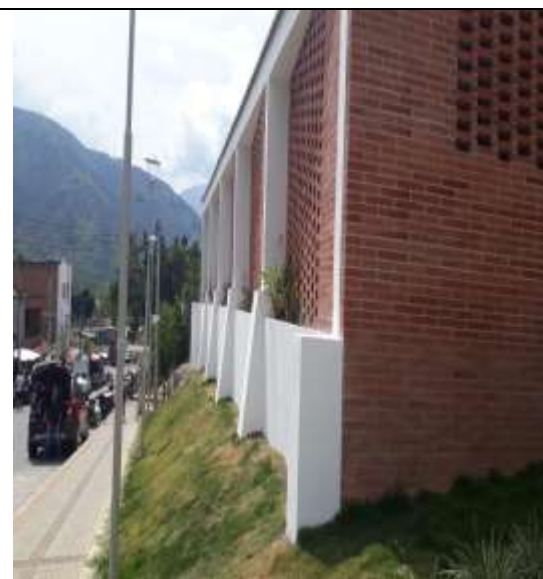
Remodelación de cubierta
