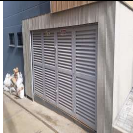
Suministro e instalación planta eléctrica
