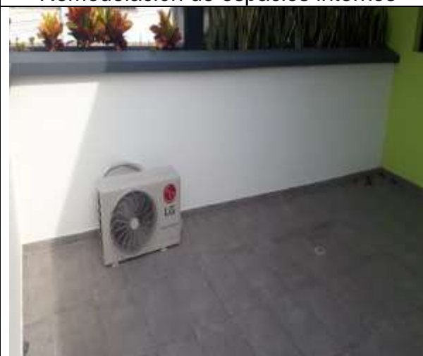
Suministro e instalación acondicionado
