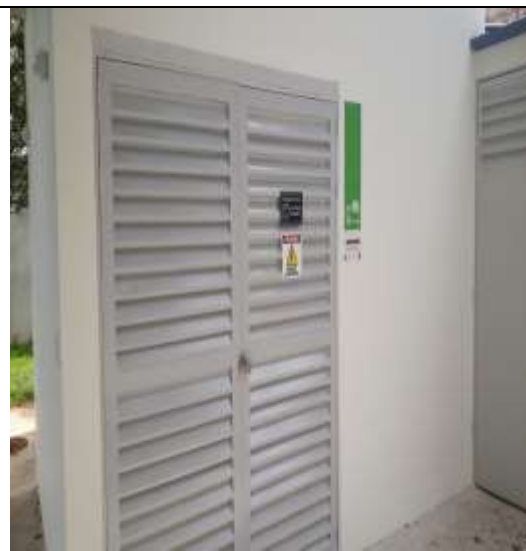
Suministro e instalación planta eléctrica
