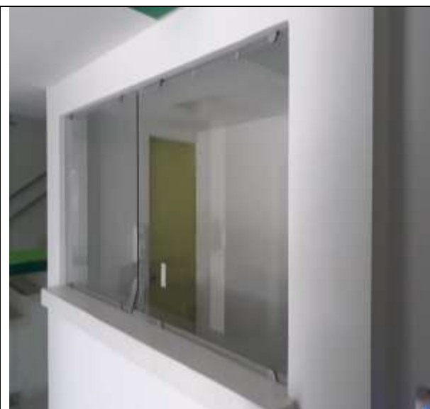
Remodelación de espacios internos
