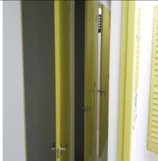
Remodelación espacios residuos solidos
