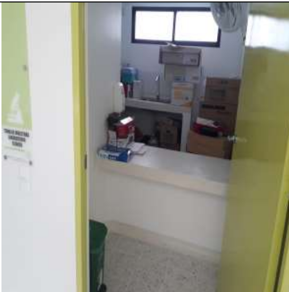
Remodelación de espacios internos
