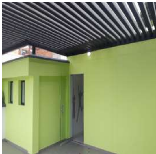
Remodelación de cubierta
