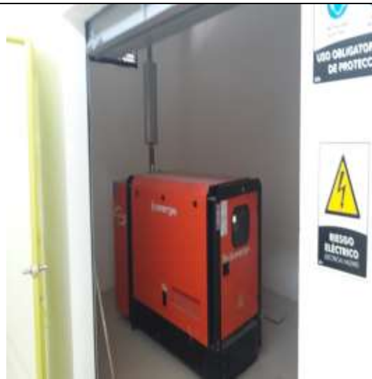
Suministro e instalación planta eléctrica
