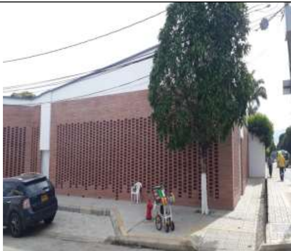
Remodelación de cubierta
