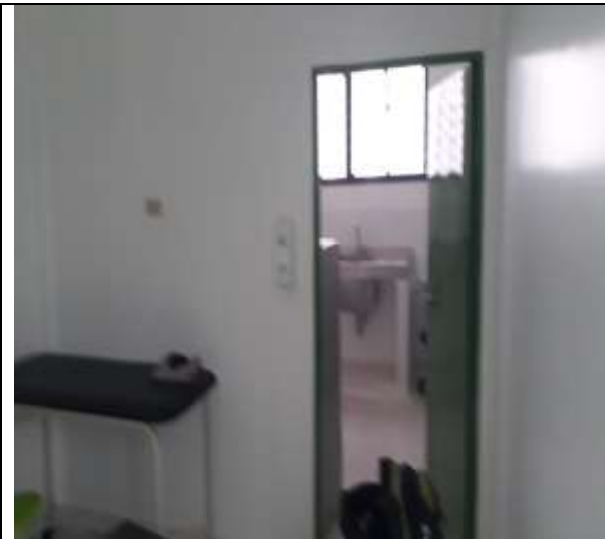
Remodelación de espacios internos
