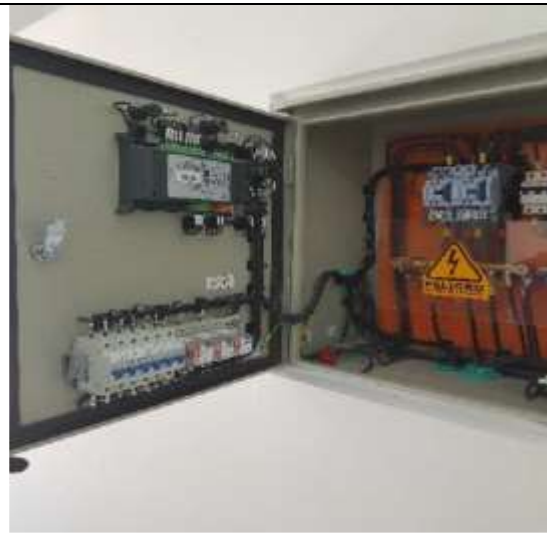
Suministro e instalación planta eléctrica
