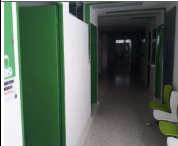
Remodelación de espacios internos
