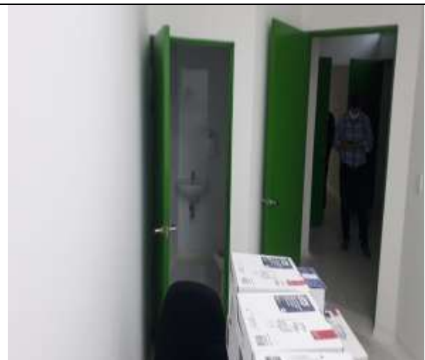
Remodelación de espacios internos
