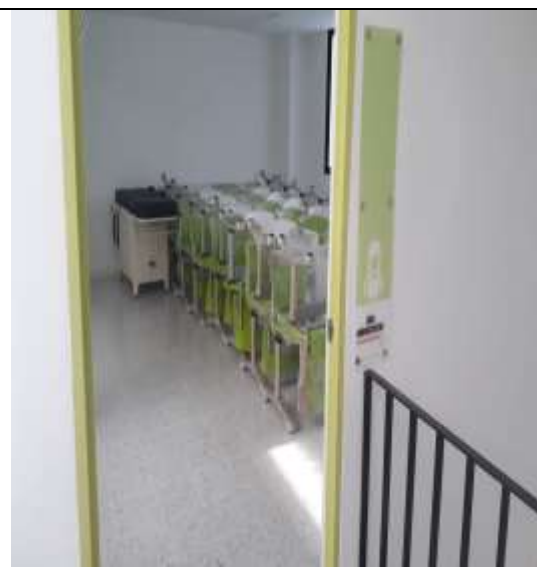
Remodelación de espacios internos
