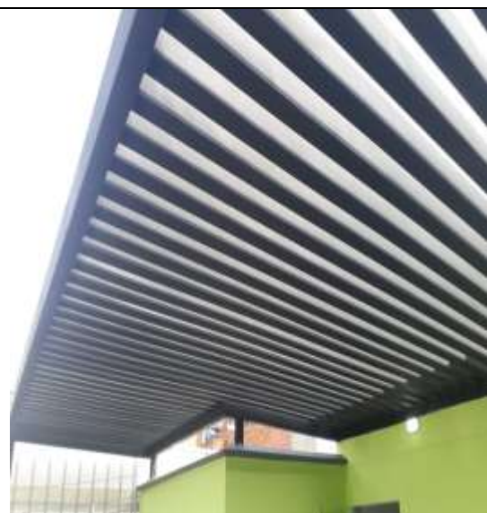
Remodelación de cubierta
