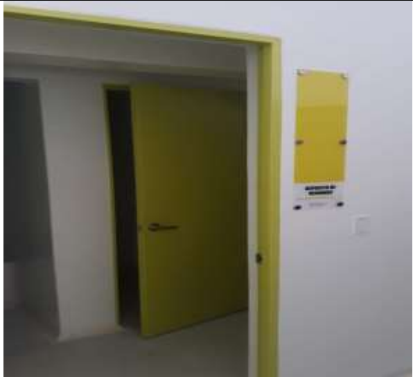
Deposito residuos solidos
