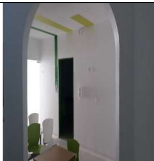
Remodelación de espacios internos
