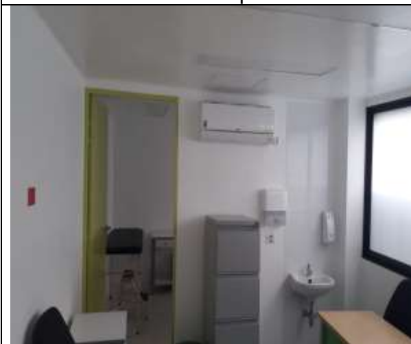
Suministro e instalación acondicionado
