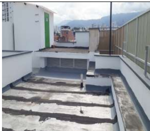
Remodelación de cubierta
