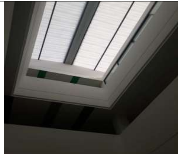
Remodelación de cubierta
