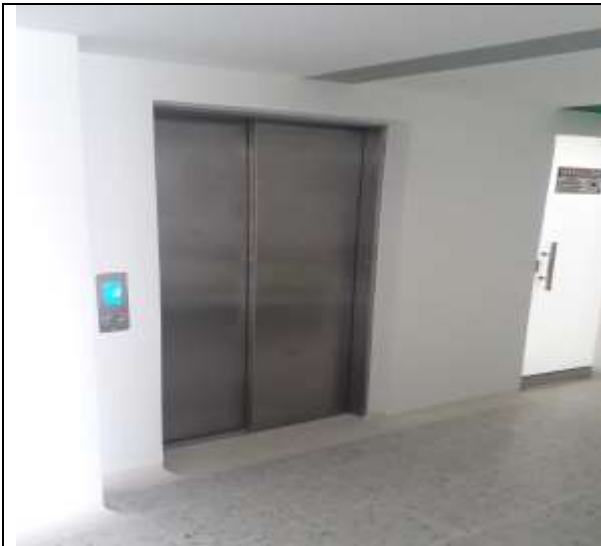
Suministro e instalación ascensor
