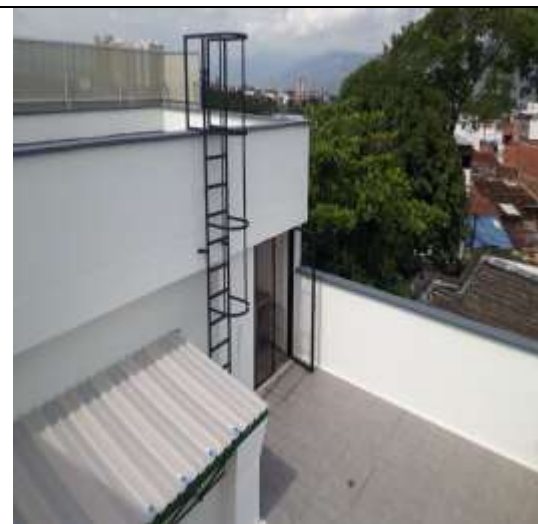
Remodelación de cubierta
