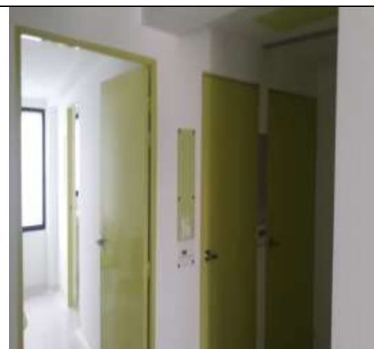
Remodelación de espacios internos
