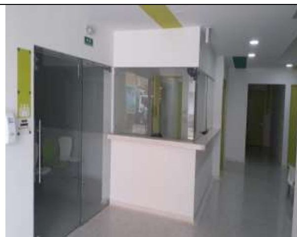
Remodelación de espacios internos
