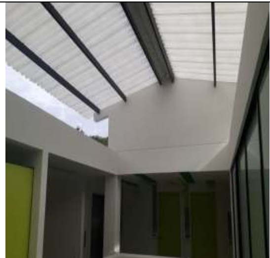
Remodelación de cubierta
