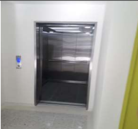
Suministro e instalación ascensor
