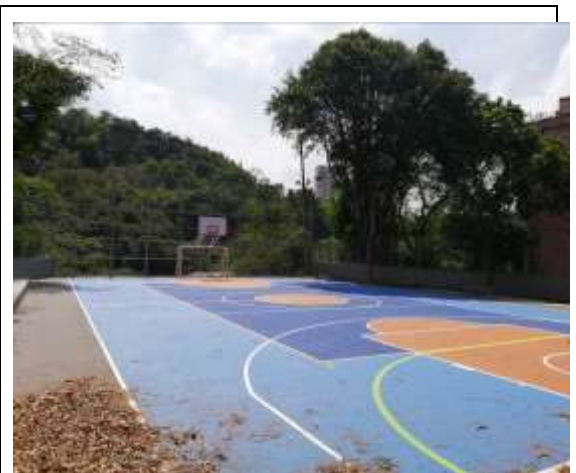
Fotografía 37 Acabado sintético sobre piso en asfalto
