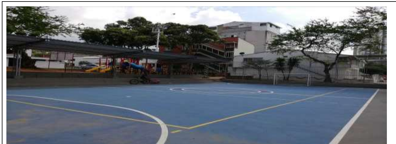
Fotografía 31 Acabado sintético sobre asfalto de piso
