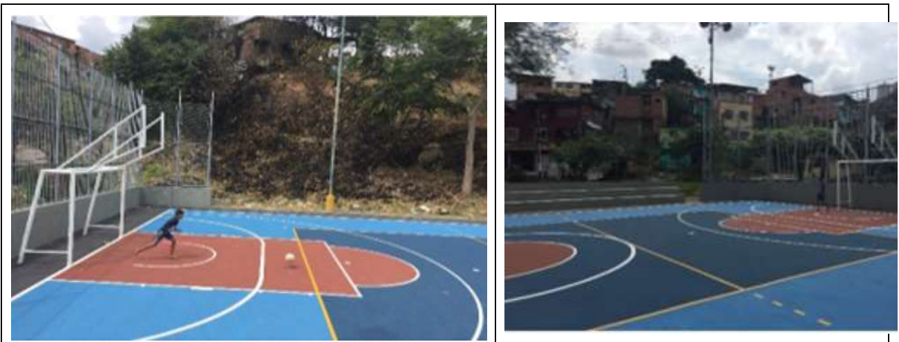
Fotografía 6 Estado Final del escenario deportivo
