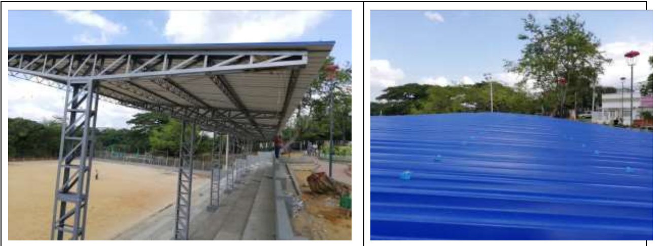
Fotografía 13. Estado final de cubierta en gradería costado oriental
