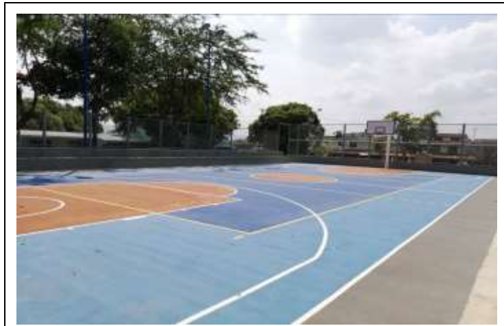
Fotografía 21. Estado final de cancha y gradería.
