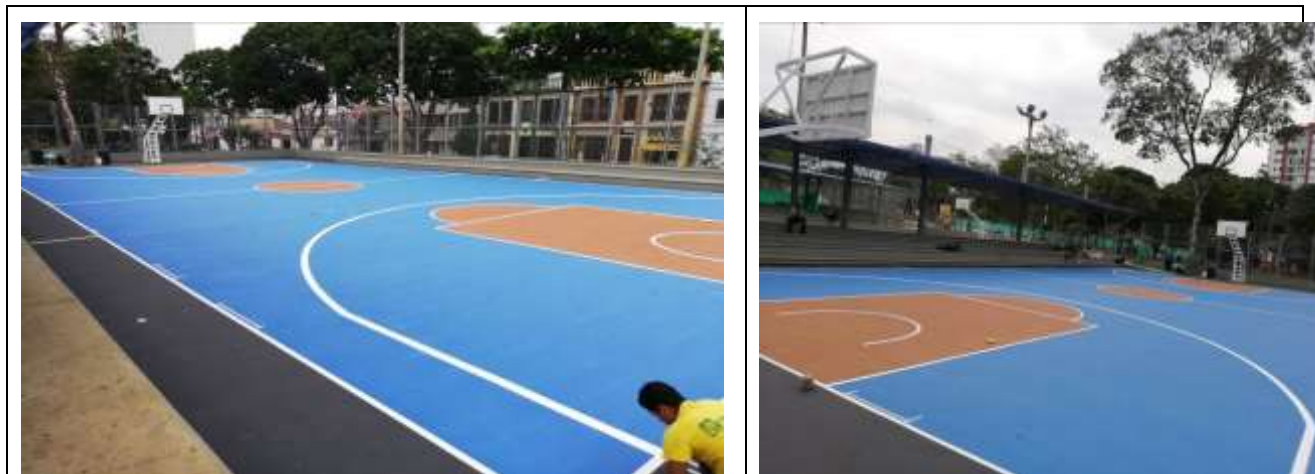
Fotografía 33 Acabado sintético sobre piso en asfalto
