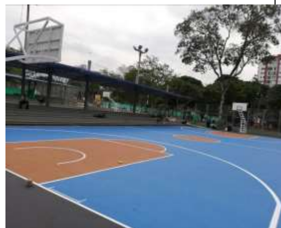
Fotografía 33 Acabado sintético sobre piso en asfalto
