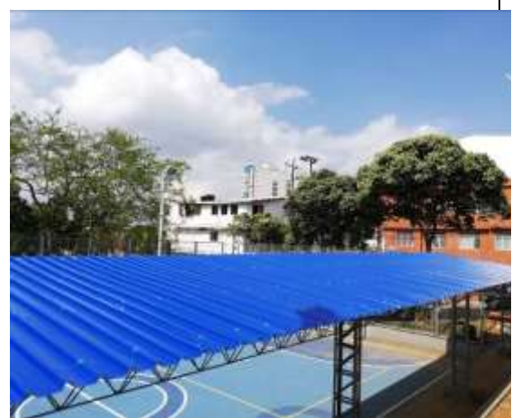
Fotografía 30 Cubierta reemplazada sobre la gradería
