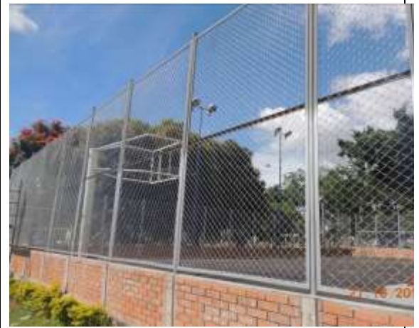
Fotografía 22. Estado final cerramiento en costado occidental.
