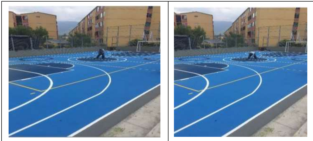
Fotografía 9 Estado final de cancha múltiple
