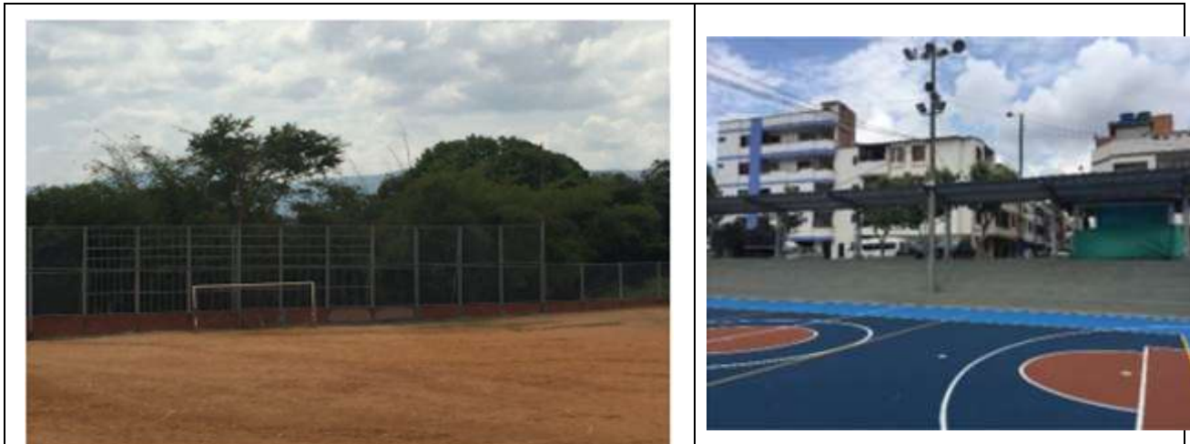
Fotografía 2 Estado Final del escenario deportivo
