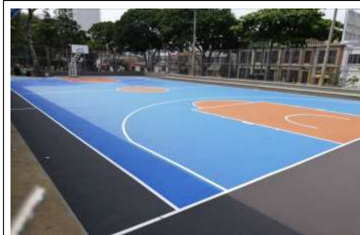
Fotografía 34 Acabado sintético sobre piso en asfalto
