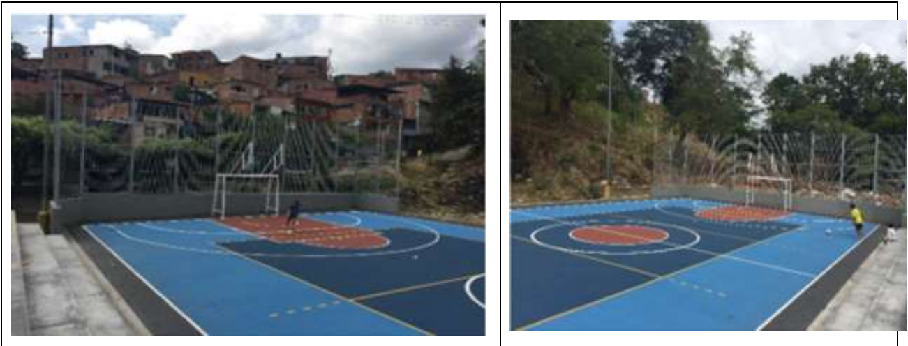
Fotografía 5 Estado final del escenario deportivo
