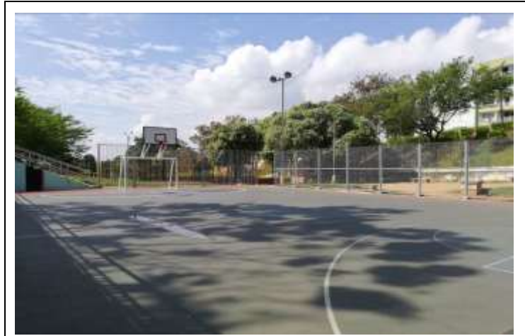
Fotografía 25. Estado final del escenario deportivo
