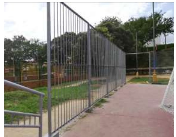
Fotografía 24. Estado final de cerramiento en varilla en costado sur.
