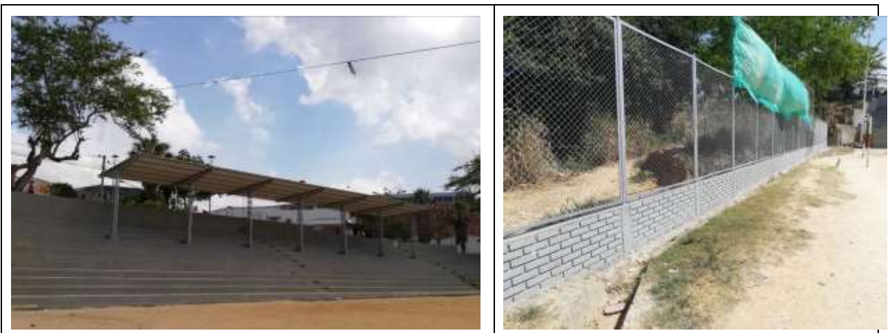
Fotografía 14. Estado final de gradería costado oriental y cerramiento en costado norte.
