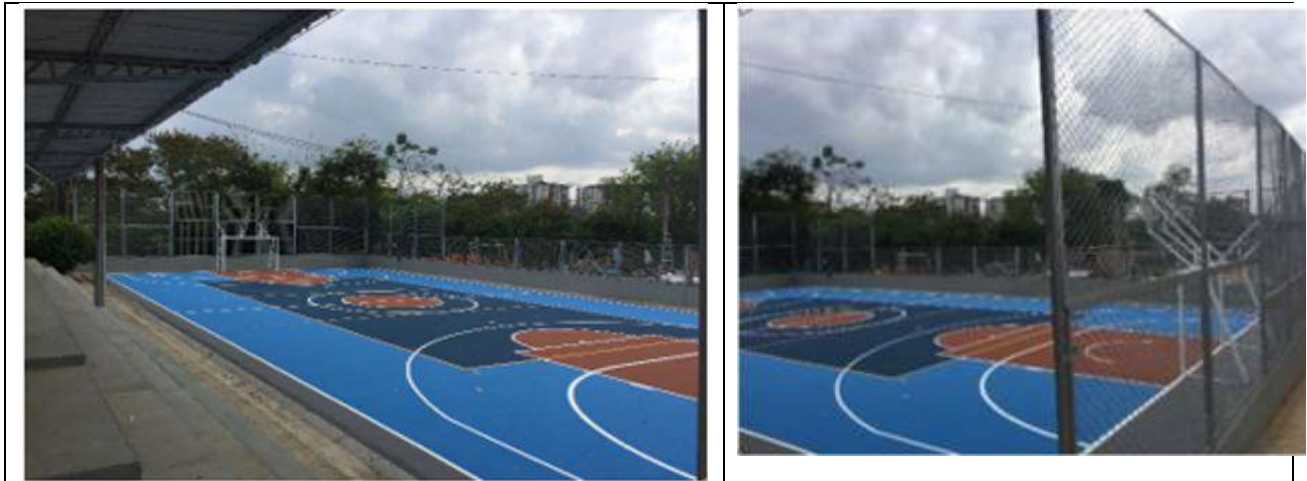
Fotografía 1. Estado final del escenario deportivo
