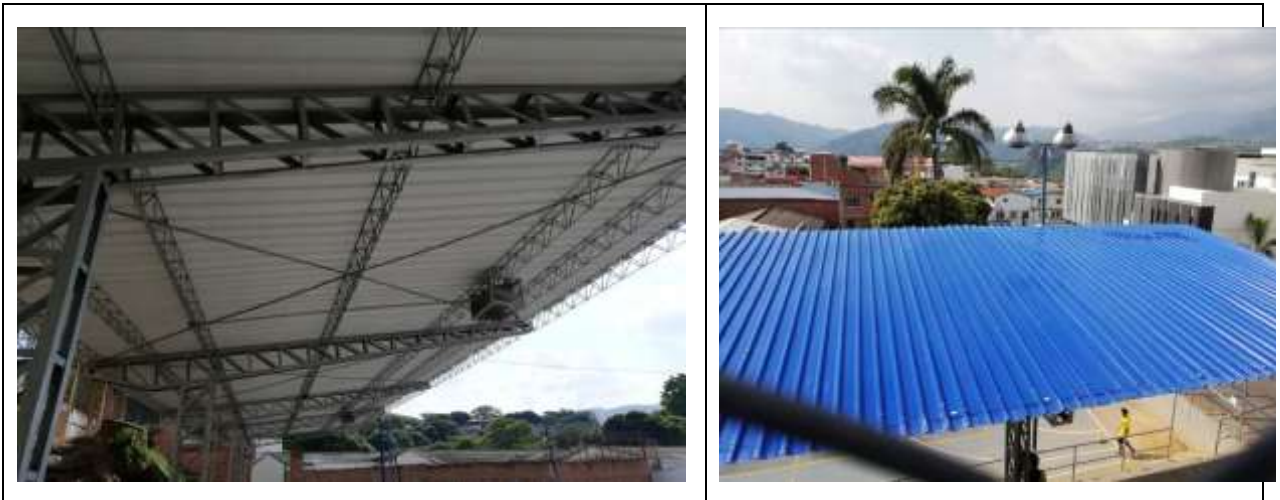
Fotografía 8 Estado final cubierta del escenario deportivo
