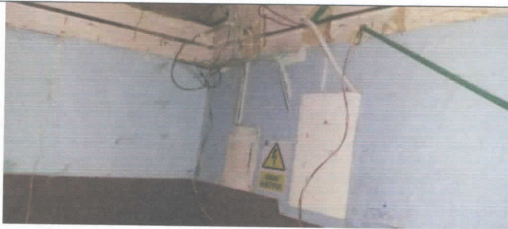
Reparación de sala de audiovisuales
