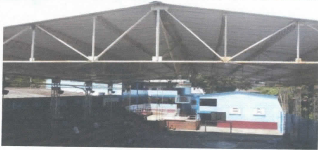
Cancha y cubierta de la misma en buen estado
