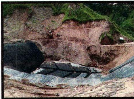
Ilustración 4. Filtros perimetrales nueva Cárcava
