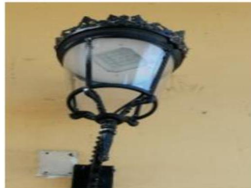
Se debe corregir posible oxidación y presentar certificación del fabricante del poste donde indique que es galvanizado en caliente y terminados en pintura electrostática.
